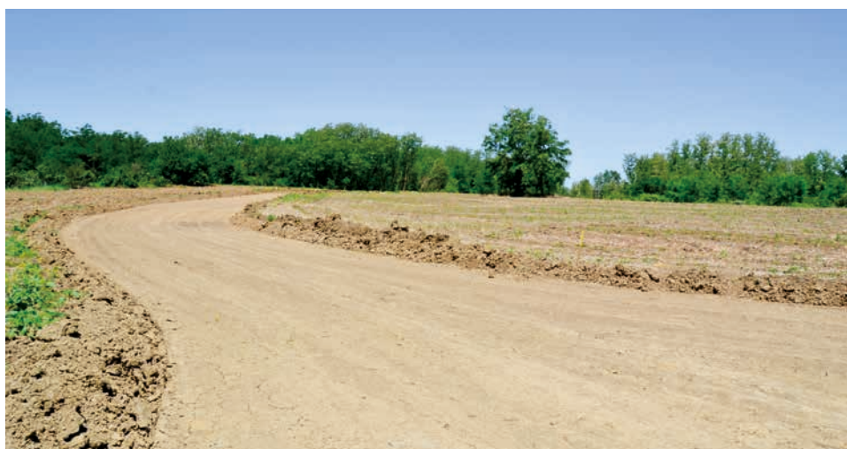
■ Будућа локација генератора у Петки
